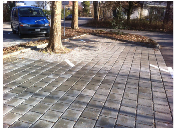
...wird mit dem Einbau von Betonsteinen mit breiten Fugen wasserdurchlässig.
