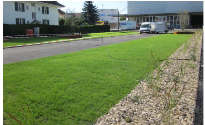
Der mit Kunststoffwaben befestigte und begrünte Parkplatz weist eine hohe Wasserdurchlässigkeit auf. (Foto oben + unten: Bächler+ Güttinger AG, Kiesen)
