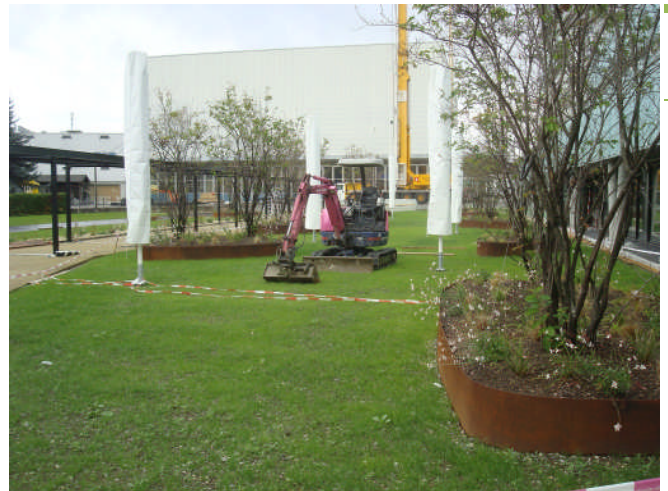
Neu erstellter Schotterrasen (Foto: Bächler+ Güttinger AG, Kiesen)
