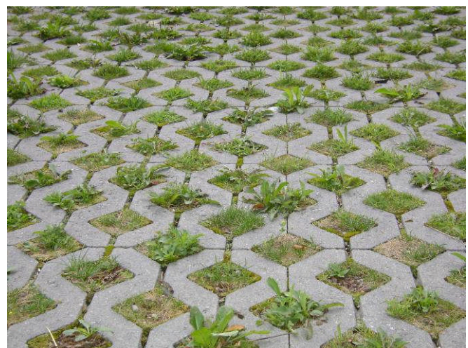
Parkplatz mit Rasengittersteinen
