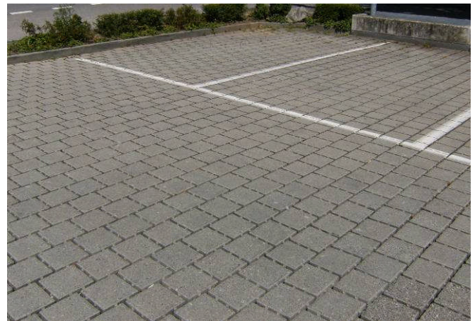
Betonsteinpflasterung mit Distanznocken
