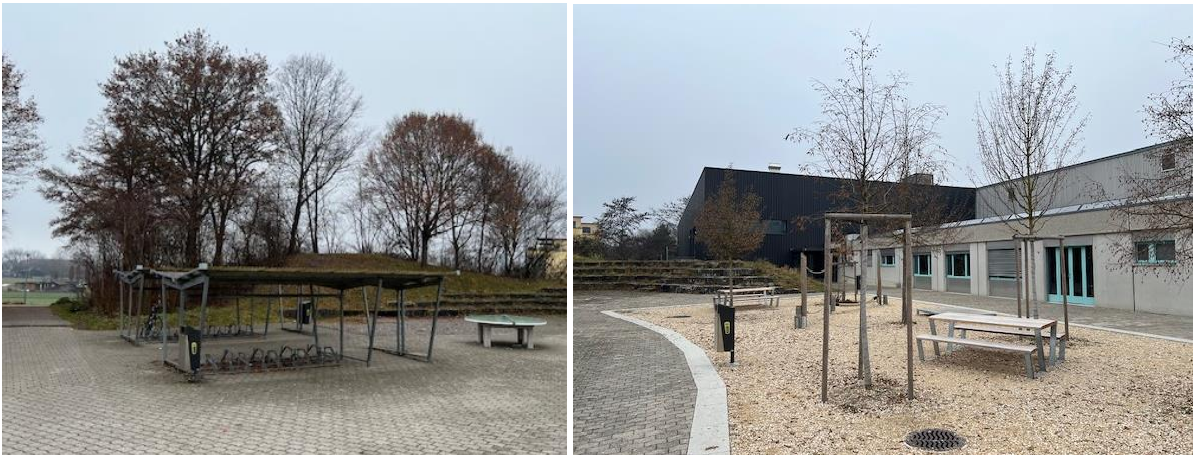
Abb.1+2: Schulanlage Moos west- und nordwestseitig; bestehender und neugestalteter Aussenbereich
