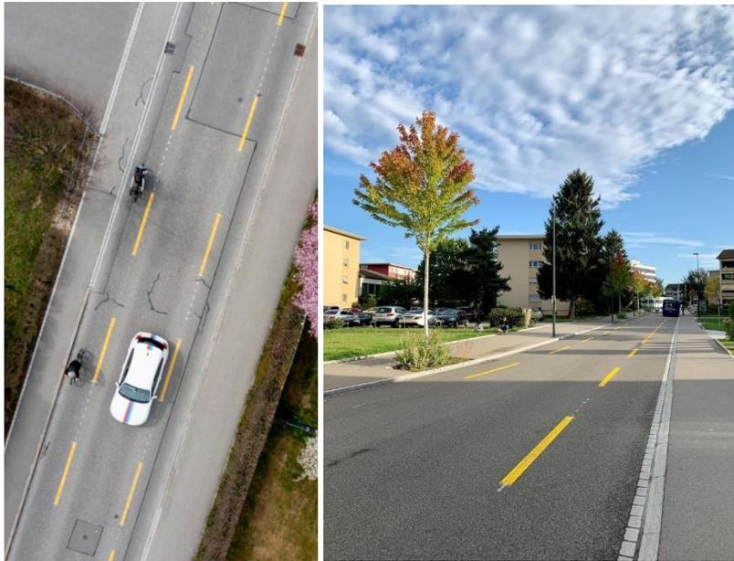
Abbildung 27 Beispiel schmale Kernfahrbahn (<https://www.velojournal.ch/aktuell/nachrichten/detail/testversuch-zeigt-erfolg/>)
