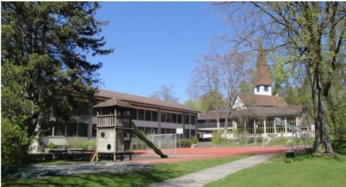
Abbildung 1: Schulanlage Horbern mit Klassentrakt (links) und Turnhalle/Tagesschule (rechts)
