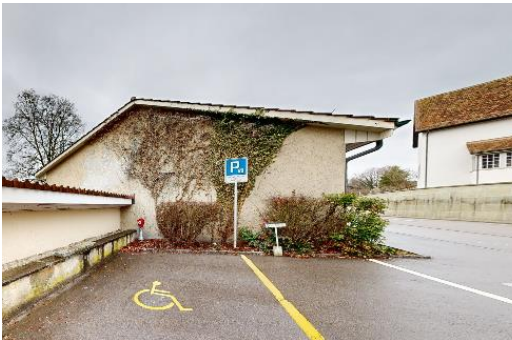
Abbildung 27 Stirnfassade Turnhalle - inkl. Kunst am Bau
