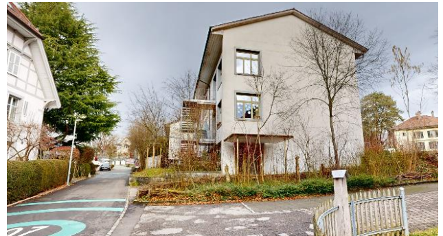
Abbildung 23 Klassentrakt Stirnfassade Südwest
