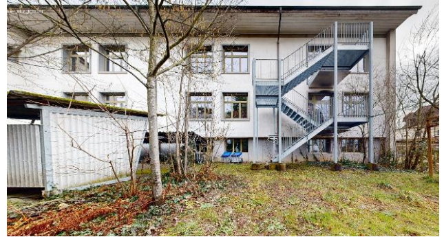
Abbildung 21 Klassentrakt Fassade Nordost
