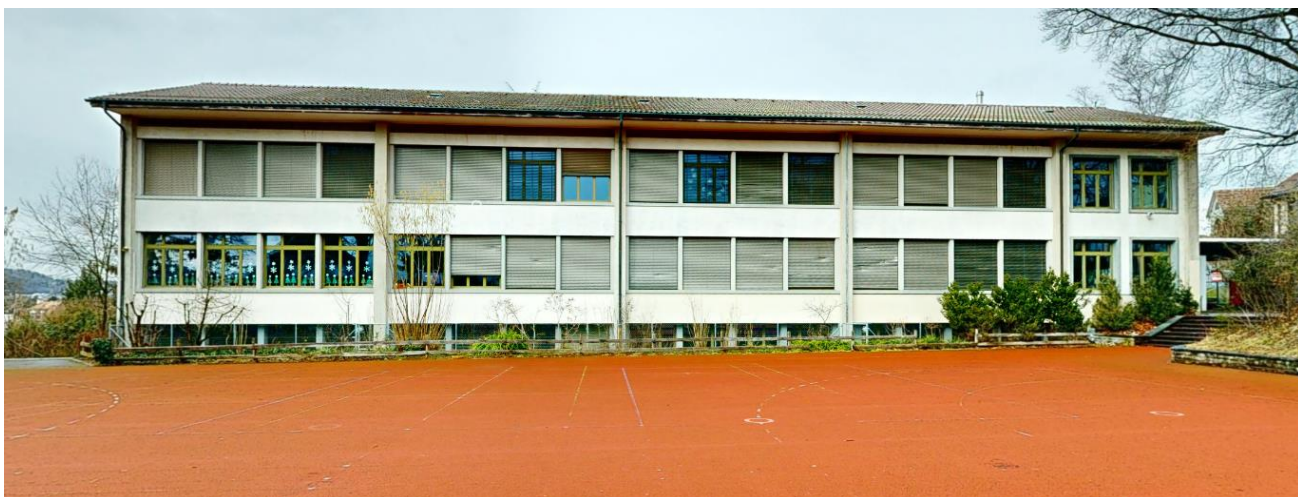
Abbildung 24 Turnhallentrakt Fassade NW
