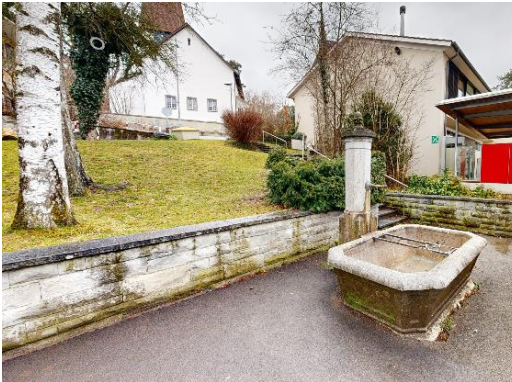
Abbildung 25 Turnhallentrakt Fassade NW
