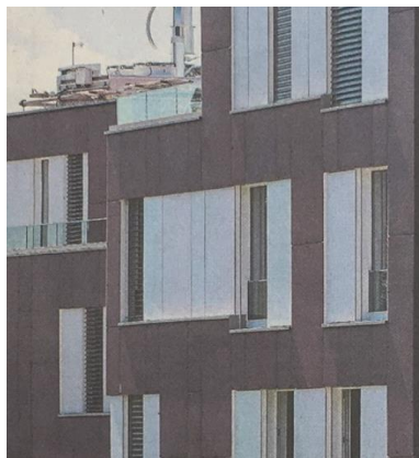
Drei Beispiele von Fassaden-Photovoltaik: Solarglas-Fassaden können in allen Mustern und Farben bestellt werden. Quellen: https://megasol.ch/referenzen ; Tages-Anzeiger
