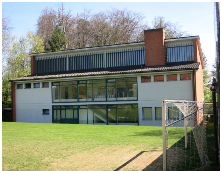
Abbildungen: Ost- und Westfassade Turnhalle sowie Nord und Südfassade Aulatrakt (Aufnahmen 2017)
