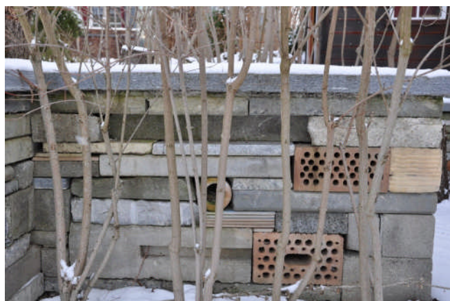
Trockensteinmauer aus Recyclingmaterial mit Unterschlupfmöglichkeiten für Tiere
