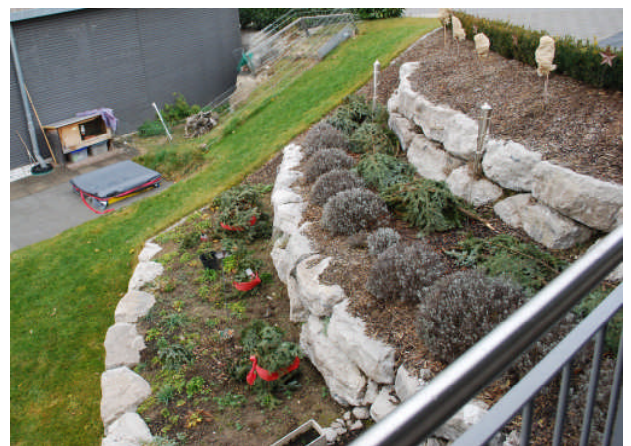
Terrassierung einer Böschung mit Blocksteinen
