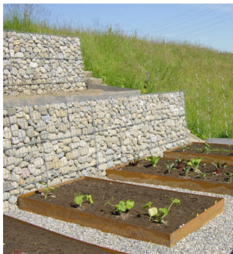
Gartengestaltung mit Drahtschotterkörben (Bild: Zollinger Stettler Gartengestaltung GmbH Bern - Laupen)
