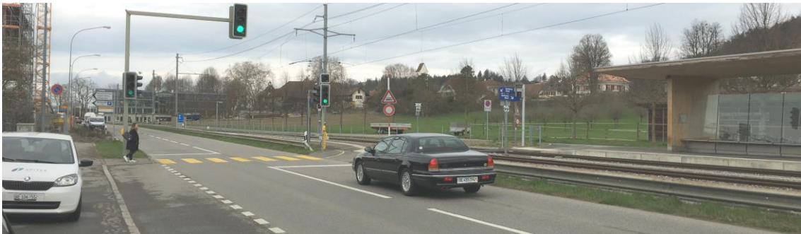
Worbstrasse und RBS-Bahnhof Siloah: Bauarbeiten während der nächsten vier Monate. (ME)
