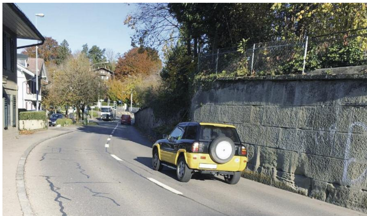
Im Zuge der Sanierung von Schloss- und Kirchenmauer wird auf der Thunstrasse mehr Platz und mehr Sicherheit für den Velo- und Fussverkehr geschaffen. Bild: zVg
